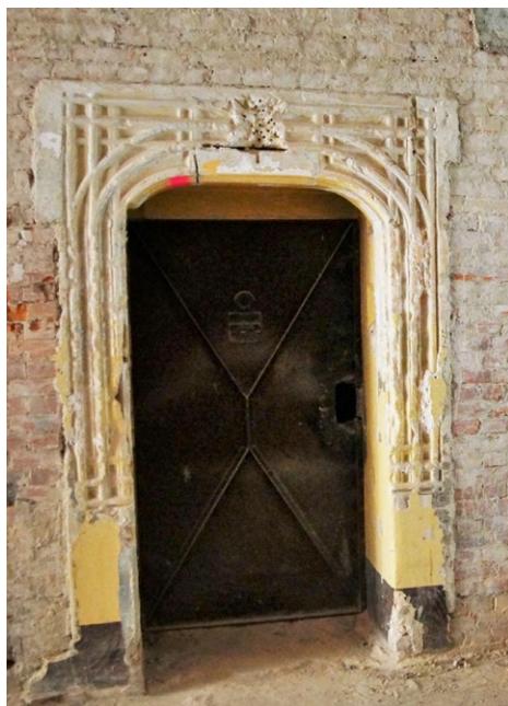
Późnogotycki portal przed renowacją. Fot. Marcin Orawski 2013
