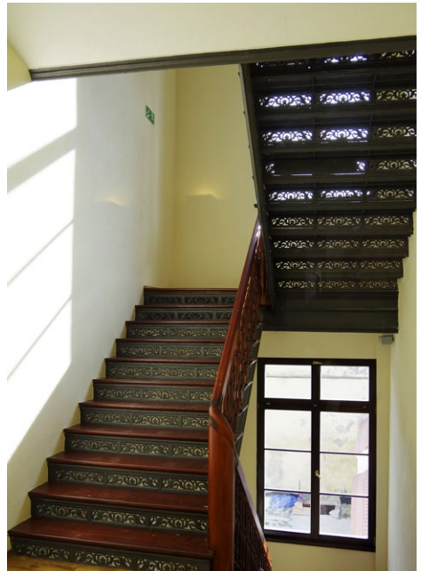
Klatka schodowa w kamienicy nr 31 przed i po renowacji, fot. M. Orawski, D. Stolarska
