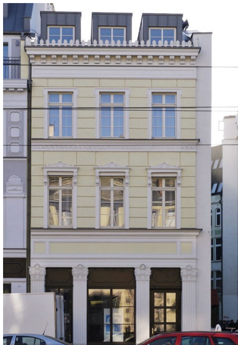
Elewacja kamienicy nr 31 w 2015 roku Fot. P.Mikrut dolny-slask.org.pl
