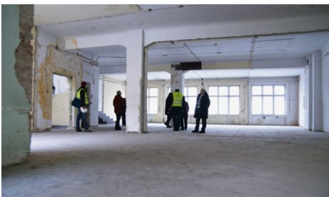
Remont sali konferencyjnej 2013r. Fot. Marcin Orawski
