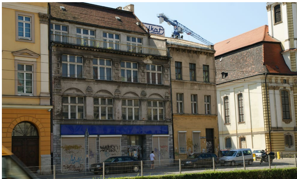
Kamienice przy Kazimierza Wielkiego 31-33 przed remontem. Fot. Marcin Orawski 2012
