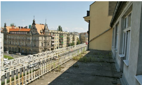
Taras na 3 piętrze w 2012 r. Fot. Marcin Orawski
